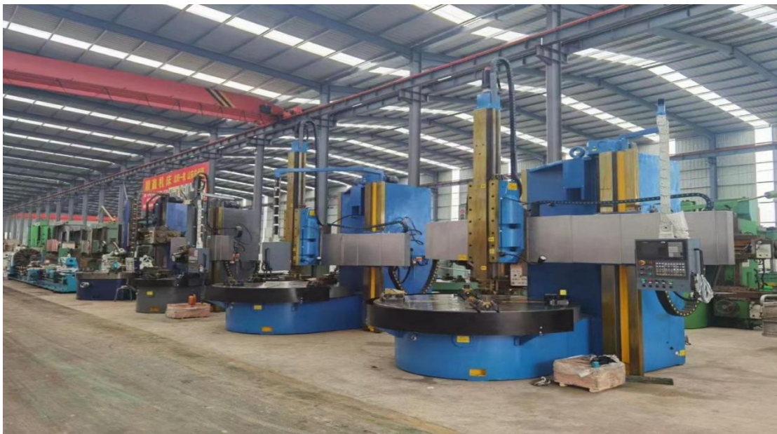
图1 齐重数控安装车间
