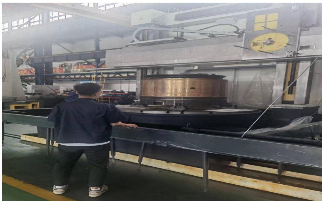
图2 车间改造现场
